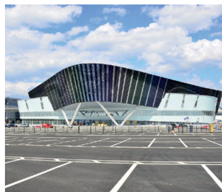
Конгресс-Холл, Екатеринбург-ЭКСПО, г. Екатеринбург
