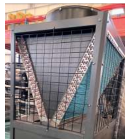
Воздушный конденсатор
