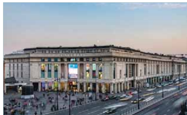
ТРЦ «Галерея» г. Санкт-Петербург — Фанкойлы Electrolux
