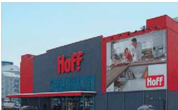
ТЦ HOFF г. Химки — Мультизональные системы Electrolux
