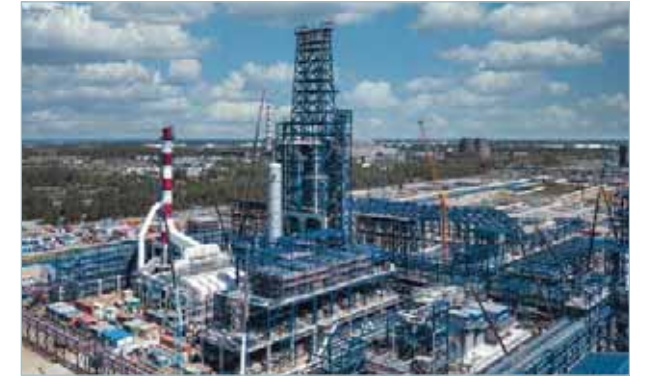
АО «ГАЗПРОМНЕФТЬ-ОНПЗ» г. Омск — Мультизональные системы Electrolux
