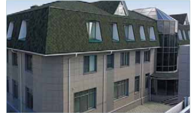
Институт инженерной физики г. Серпухов — Мультизональные системы Electrolux
