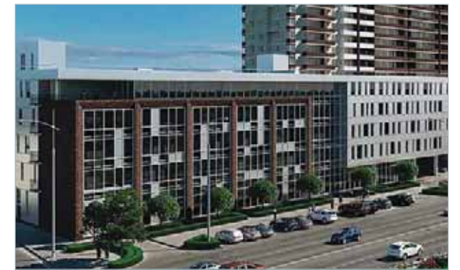
Торгово-офисный центр г. Краснодар — Мультизональные системы Electrolux
