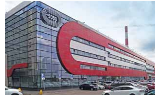
Бизнес-центр «Территория 300» г. Уфа — Мультизональные системы Electrolux
